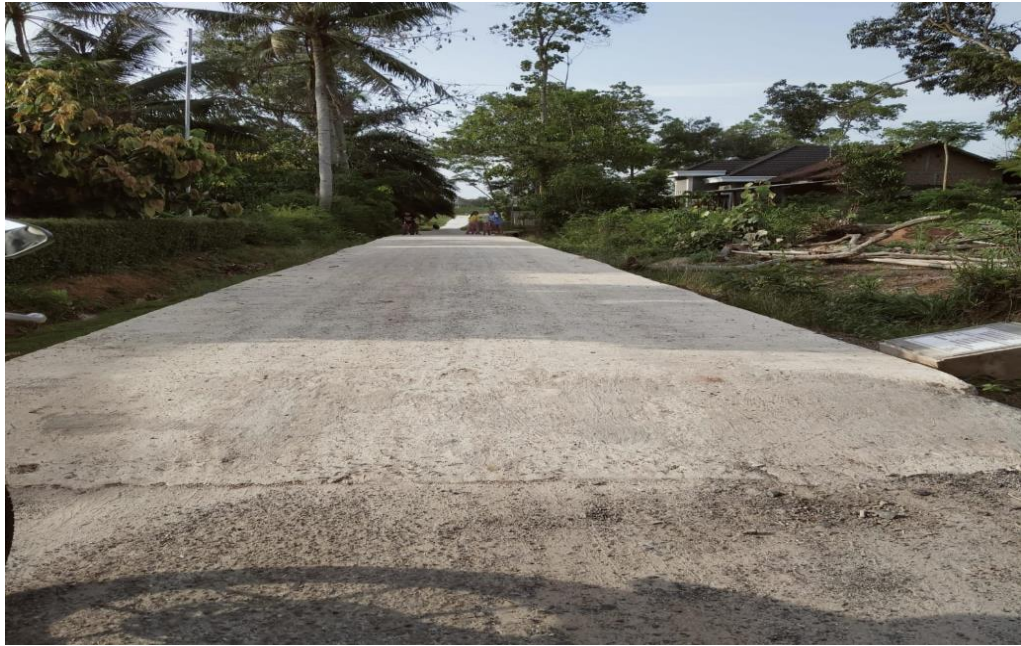
Pemberdayaan bidang infrastruktur, pembangunan jalan rigid beton antara dusun 2 dan dusun 3 kampung Bulusari
