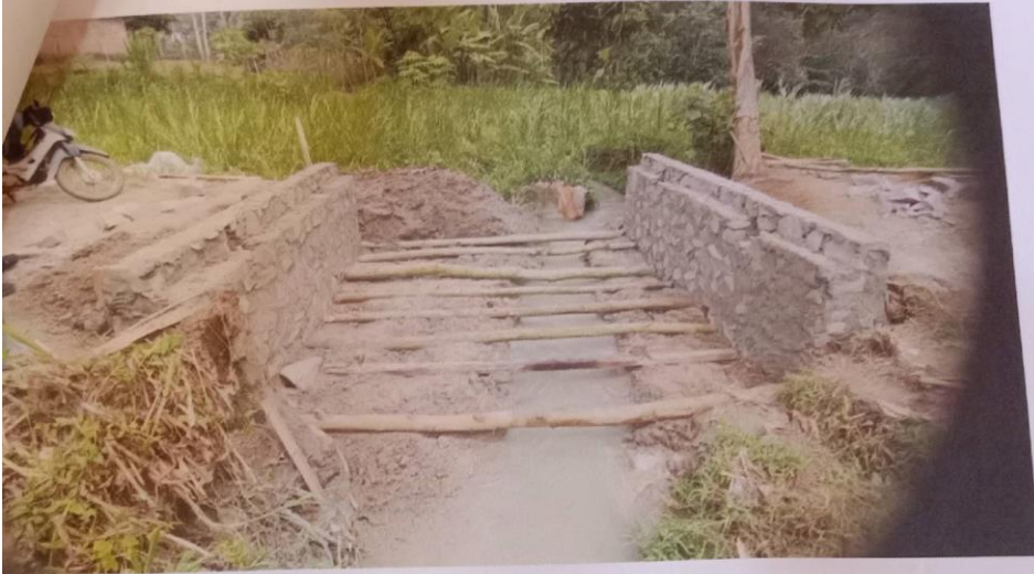
FOTO 50% PEMBANGUNAN JEMBATAN GORONG-GORONG PLAT 4X4X2
