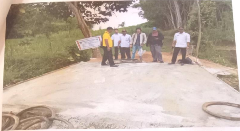
FOTO 100% PEMBANGUNAN JEMBATAN GORONG-GORONG PLAT 4X4X2
