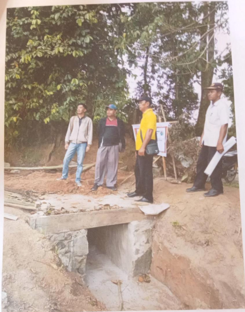
FOTO 100% PEMBANGUNAN JEMBATAN GORONG-GORONG PLAT 4 X 0,6 X 0,6
