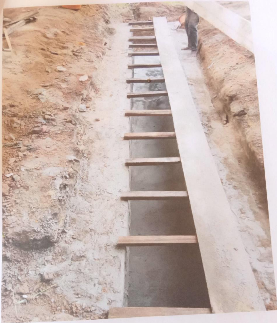
FOTO 50% PEMBANGUNAN JEMBATAN GORONG-GORONG PLAT 4 X 0,6 X 0,6
