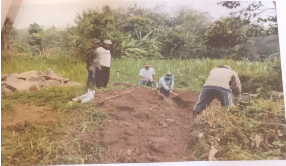
FOTO 0% PEMBANGUNAN JEMBATAN GORONG-GORONG PLAT 4X4X2
