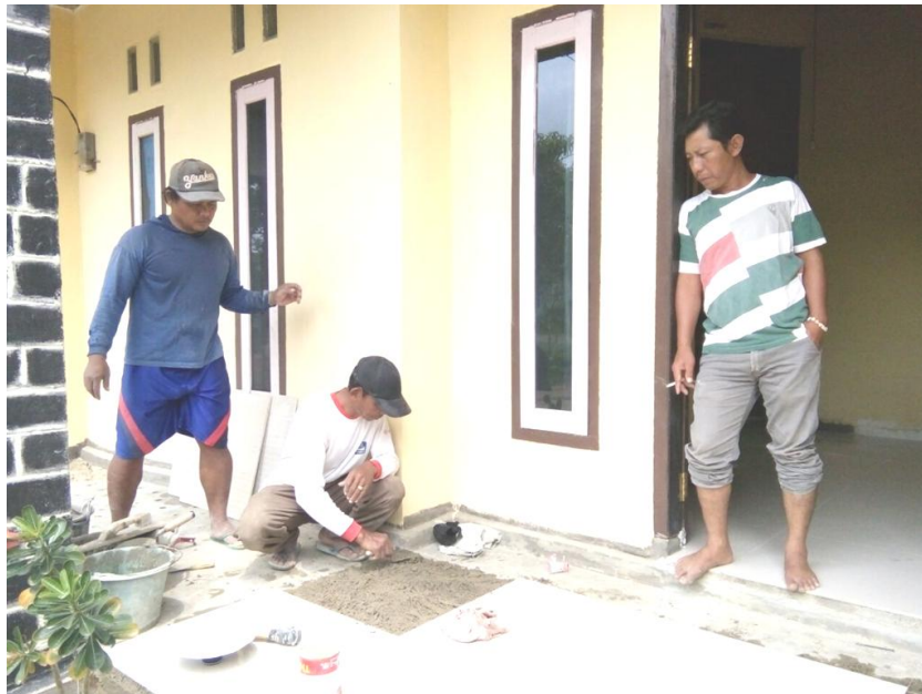
Foto 2. Proses Pengerjaan Bangunan FOTO-FOTO DOKUMENTASI
