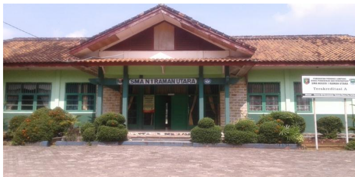
Foto 1 Gedung SMA Negeri 1 Raman Utara
