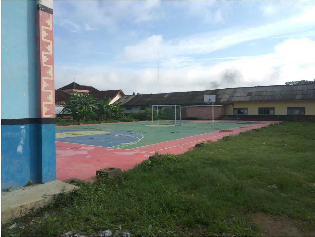
Kondisi Lapangan Basket Desa Kampung Baru Kecamatan Kotagajah
