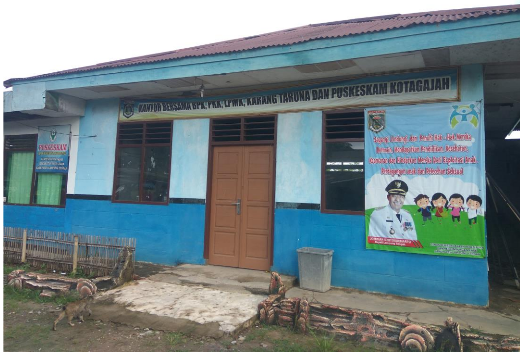
Kondisi Gedung PKK dan Puskesmas Desa Kampung Baru Kecamatan Kotagajah
