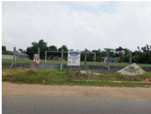
Foto pengalokasian Dana Desa untuk Pembangunan Pagar lapangan dan paping lapangan.
