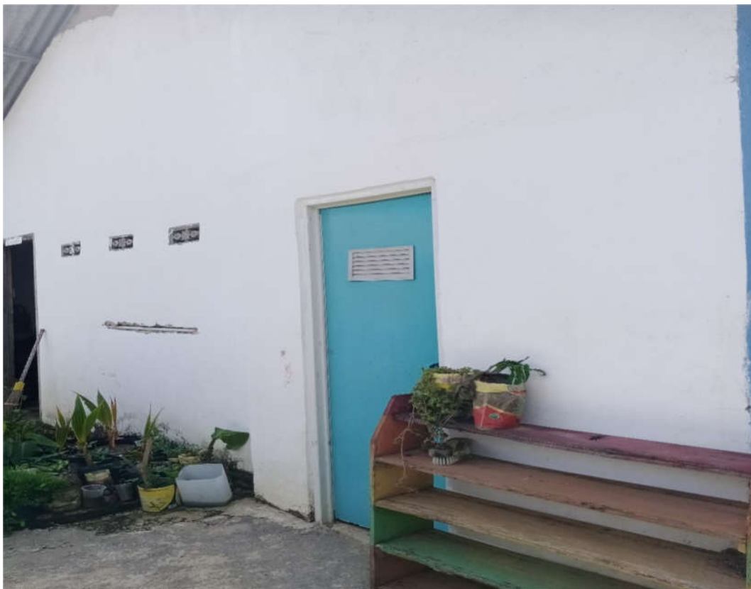
Toilet RA Al Huda Kayangan Tulung Balak
