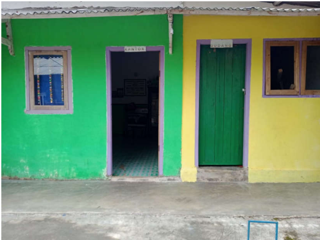
Ruang Kantor dan Gudang RA Al Huda Kayangan Tulung Balak
