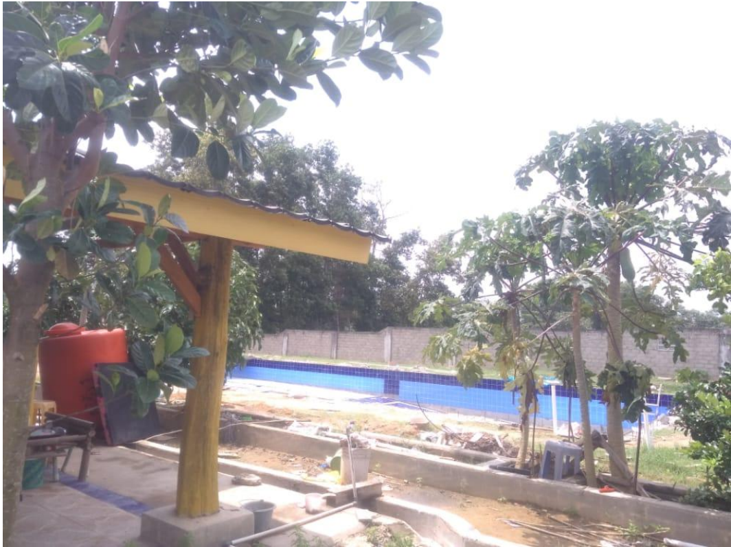
Kolam renang dewasa pada tahap awal pembangunan
