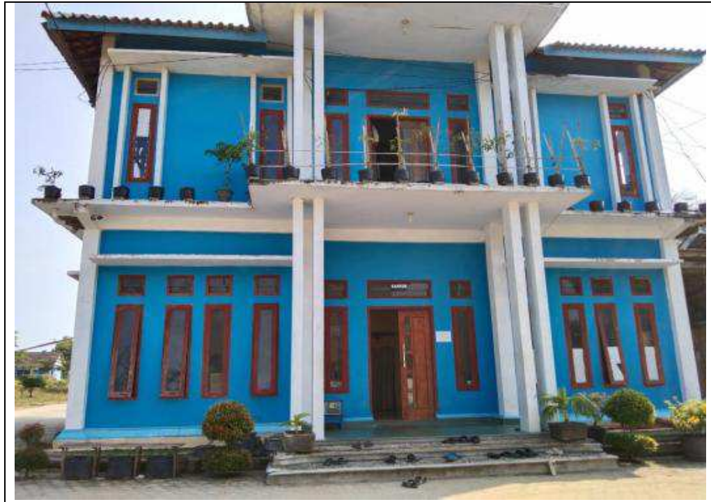
Gambar. 12 Gedung Kantor Ponpes Darussa'adah Tampak Depan
