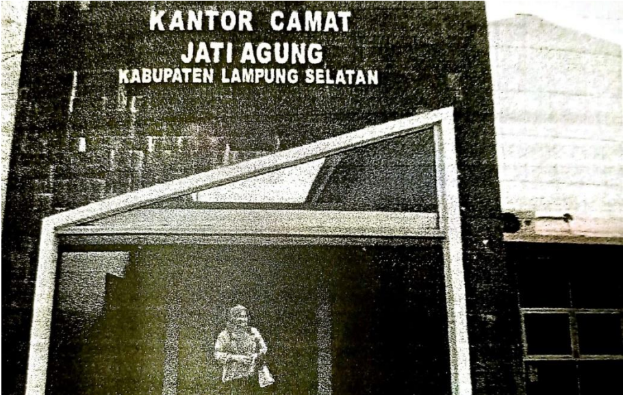
Kantor Kecamatan Jati Agung Lampung Selatan
