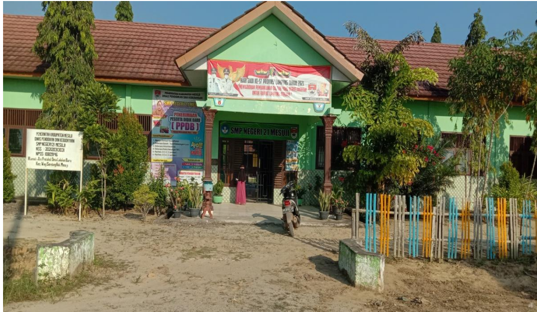
Dokumentasi Tampak Gerbang Depan SMP Negeri 21 Mesuji
