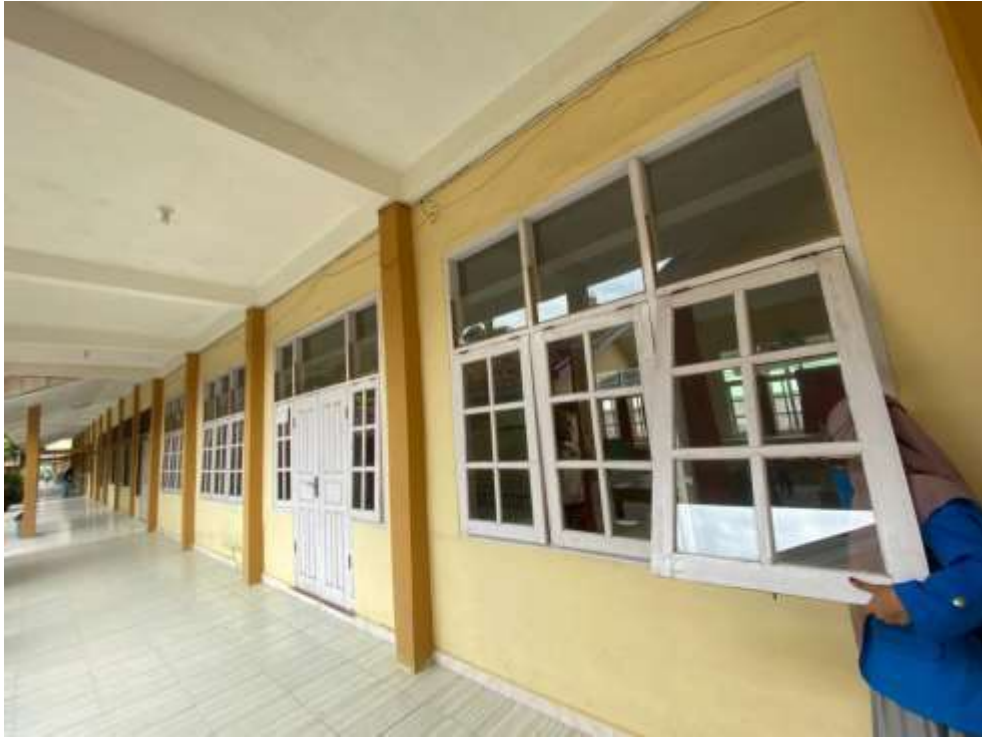
Dokumentasi Keadaan Kelas Di SMA Negeri 1 Kotagajah
