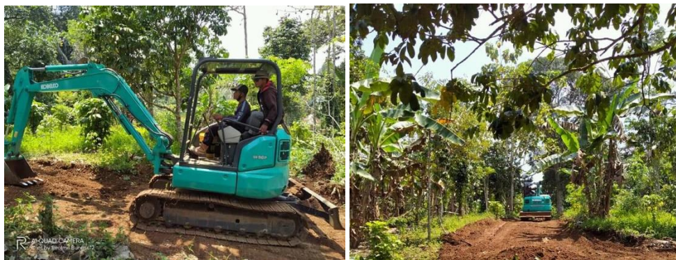
Gambar 1.6 Perluasan jalan menggunakan eskavator dari Pemkab Lamtim.
