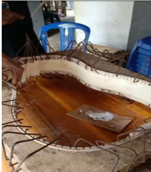
Gambar 3. Tahap pemasangan bressing dengan besi
