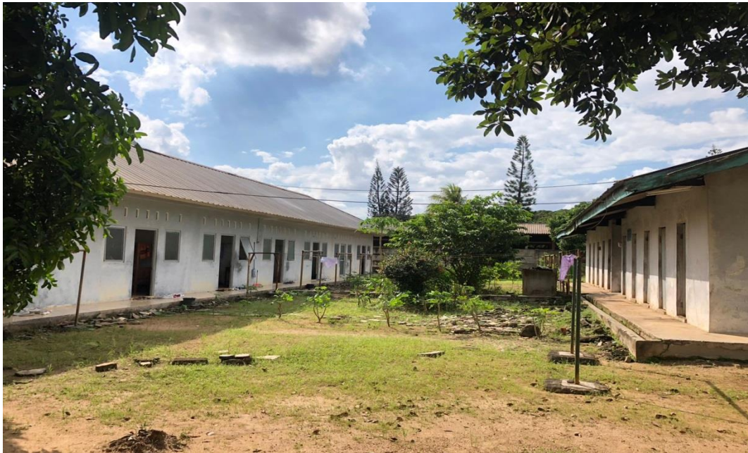
Gambar 1. Mess Bagi Para Pekerja
