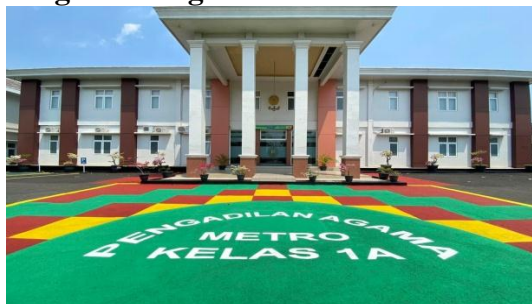
Gambar 2: Gedung Baru Pengadilan Agama Metro Jl. Stadion 248 Tejo Agung
