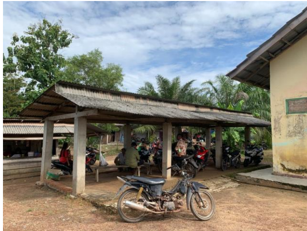
Dokumentasi Keadaan Sarana dan Prasarana SDN 01 Karya Makmur
