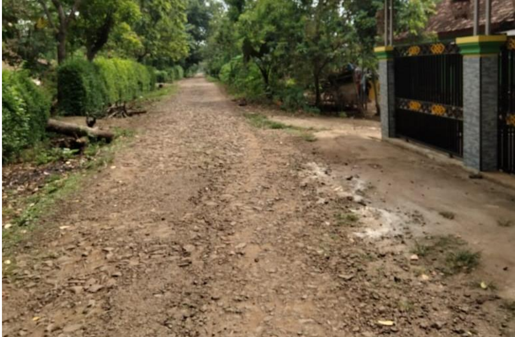
Pembukaan badan jalan
