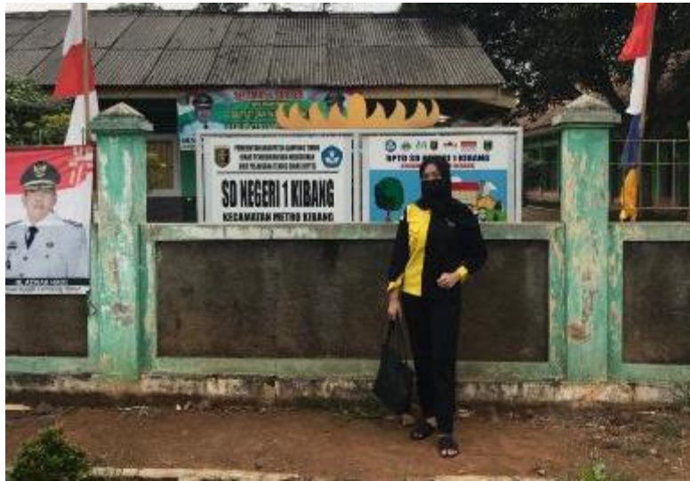
Gambar 1.7 tampak depan SDN 1 Kibang
