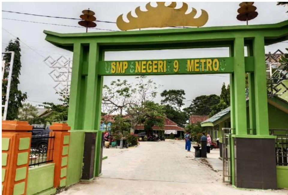
Kondisi SMP Negeri 9 Metro
