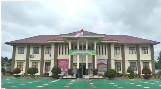
Gedung Pengadilan Agama Gunung Sugih Kelas 1B
