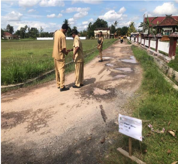
Akuntabilitas aparat perbaikan jalan kampung
