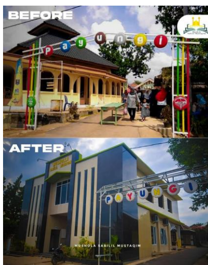
Gambar 4.2 Musala lama dan setelah di renovasi
