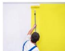
Gambar 6.2 Pekerja Mengecat Dinding
