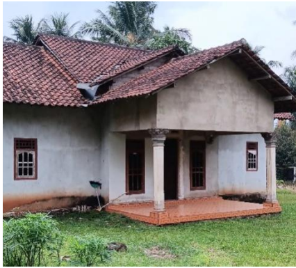
Foto rumah Ibu Homsah yang dibangun pada tahun 2015
