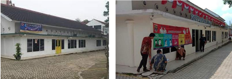
Gambar: Gedung Health Center (HC) Metro yang kini menjadi Kantor RSUD Ahmad Yani Kota Metro. Sumber: Dokumentasi penulis dan google.
