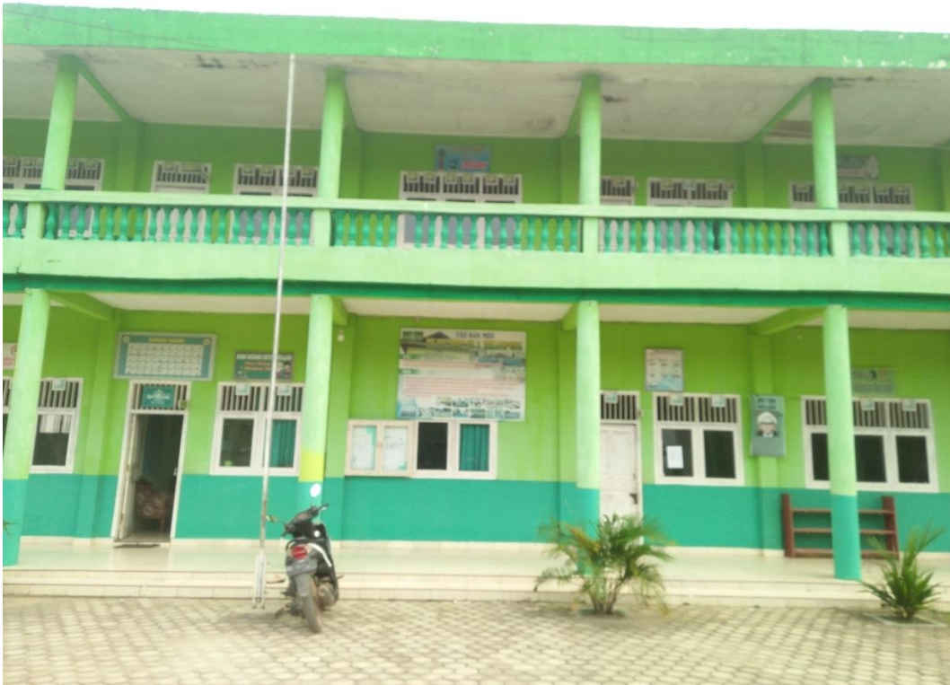
Gedung MI Ma'arif NU 5 Sekampung Tampak dari Depan
